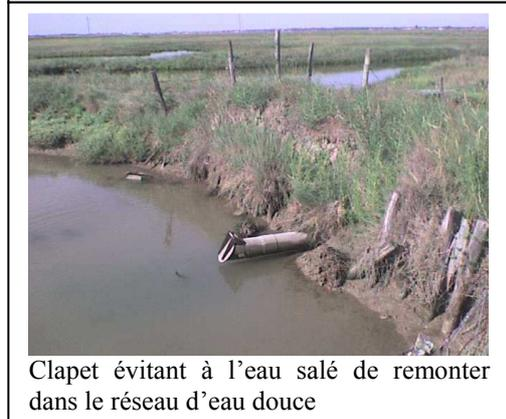
*Clapet évitant à l'eau salé de remonter dans le réseau d'eau douce*
